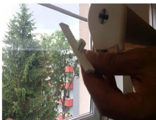
Čep pasuje do držáku a drží hřídel pomocí křížového trnu
