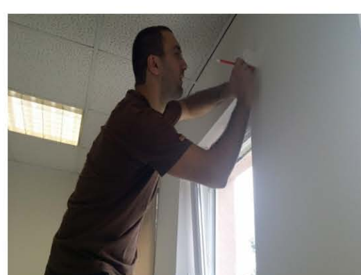
Přiložíme si držáky a vyznačíme díry pro šrouby
